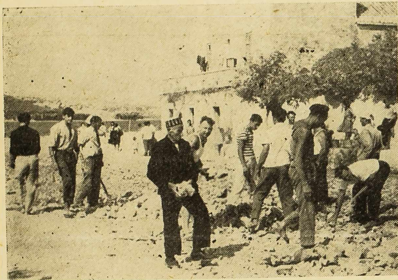
Radovi na gradilištu ceste Magistrala - Tijesno
