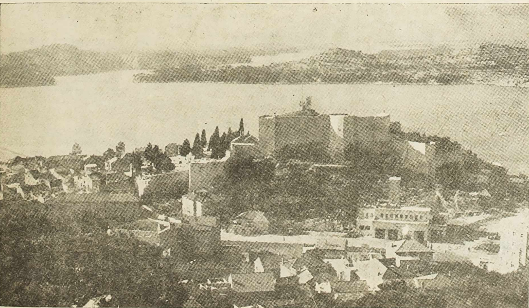
Pogled na Šibenik i Kanal
